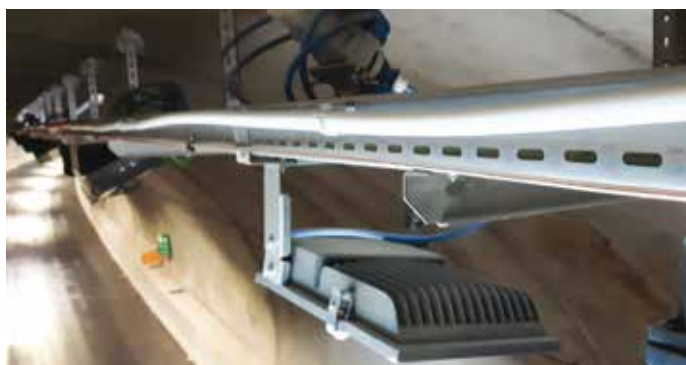
8. Particolare dell'installazione del cavo SEC20 con clip a innesto
