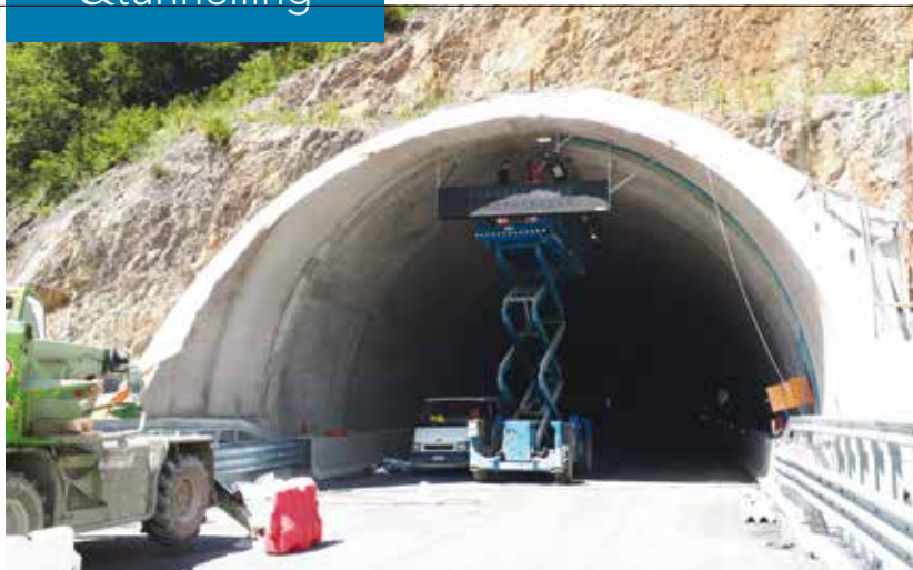
5. La fase di messa in servizio della galleria Paniga
